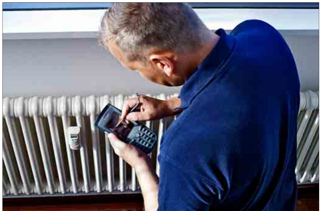
Un técnico comprueba la lectura de un calorímetro instalado en un radiador. / EL MUNDO
